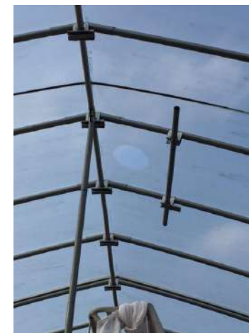
③ 補助パイプを予め仮止めしておきます。
