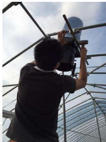
⑤ 仮止めしておいた補助パイプを挟み込むように固定します。
