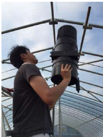
④ 予めビス止めした空動扇の中心をあて、垂直に上に突き上げます。
