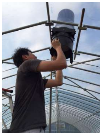
④ 予めビス止めした空動扇の中心をあて、垂直に上に突き上げます。
