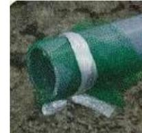
※排水部には左の写真のように塩ビ管に別のネットを巻き、暗渠パックが流れ出ないようにします
