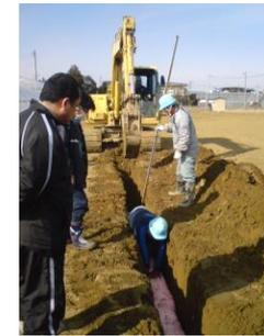
図-5 有孔パイプ、土管を用いない場合
